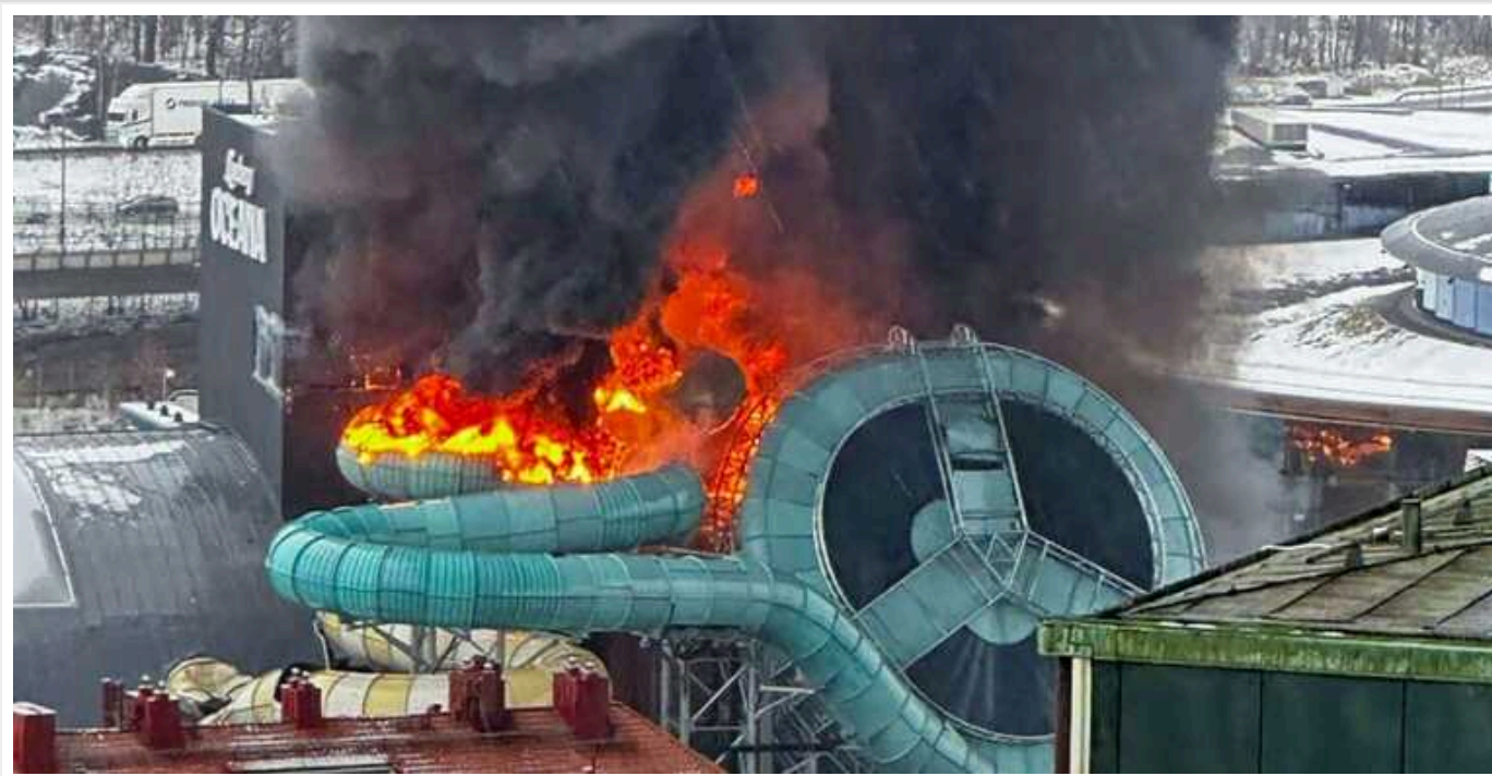
У Швеції в парку розваг у Гетеборзі спалахнув аквакомплекс: є постраждалі
