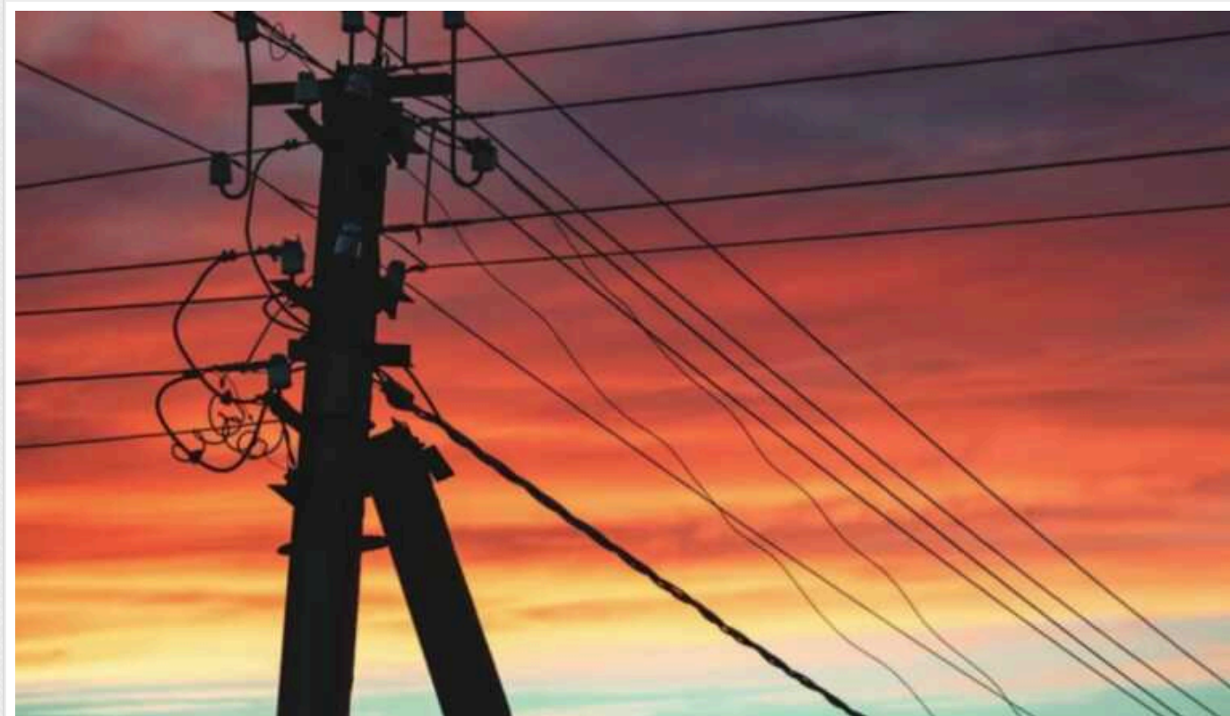
У результаті атаки БПЛА пошкоджена підстанція "Укренерго": Кривий Ріг залишився без світла
