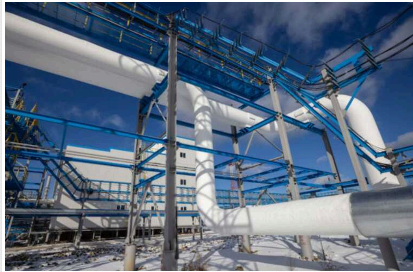
Великий газопровід з РФ до КНР затримується у будівництві - FT
