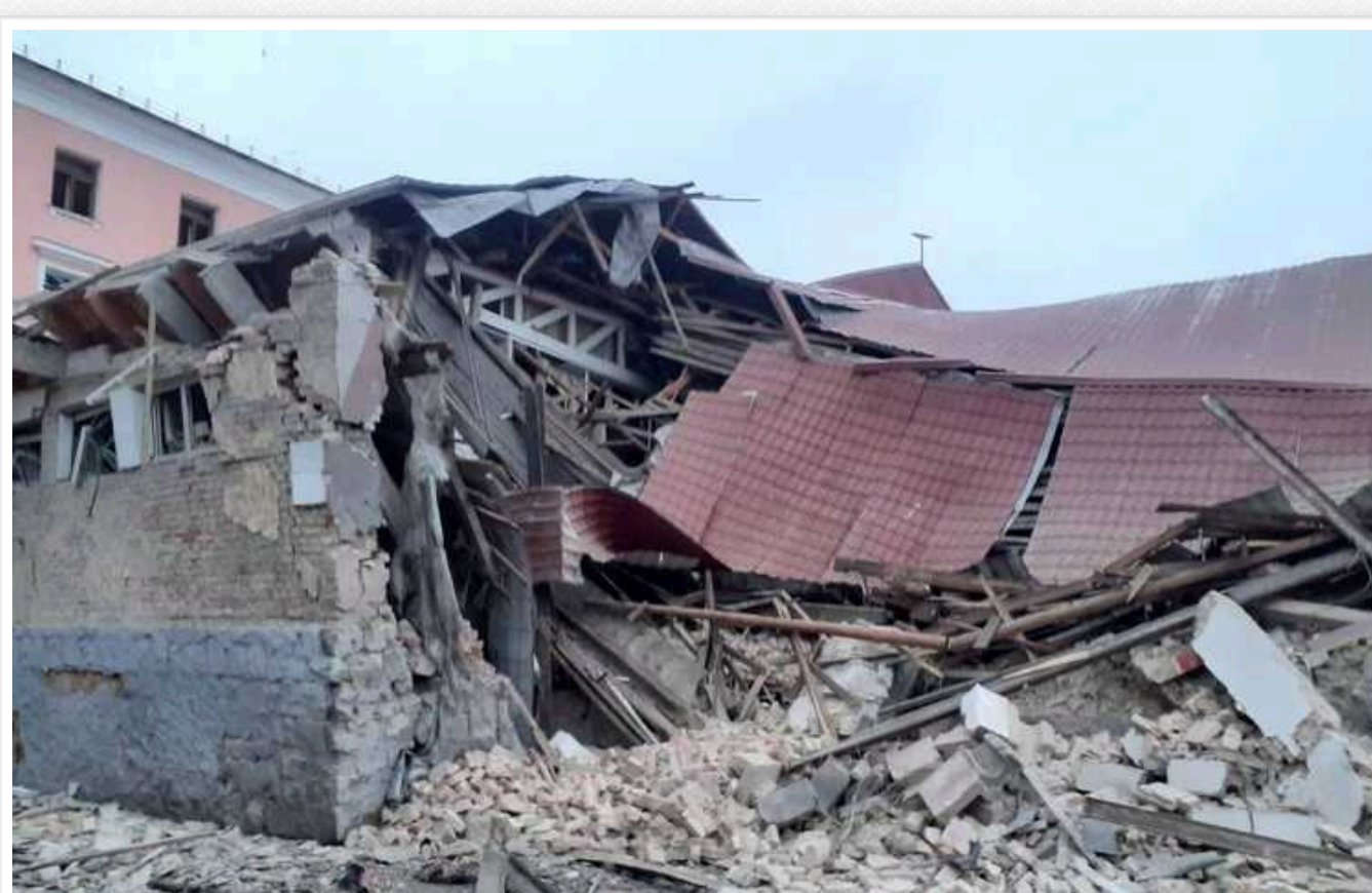
У Києві пошкоджений спортивний комплекс "Укрзалізниці" "Локомотив"
