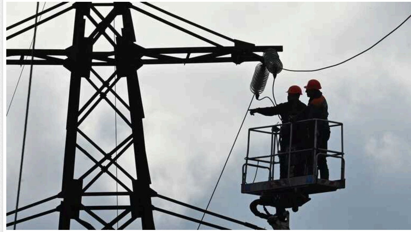
Щоб прибрати залежність Одещини від росіян, «Укренерго» за 3,7 млрд замовило будівництво лінії електропередач
