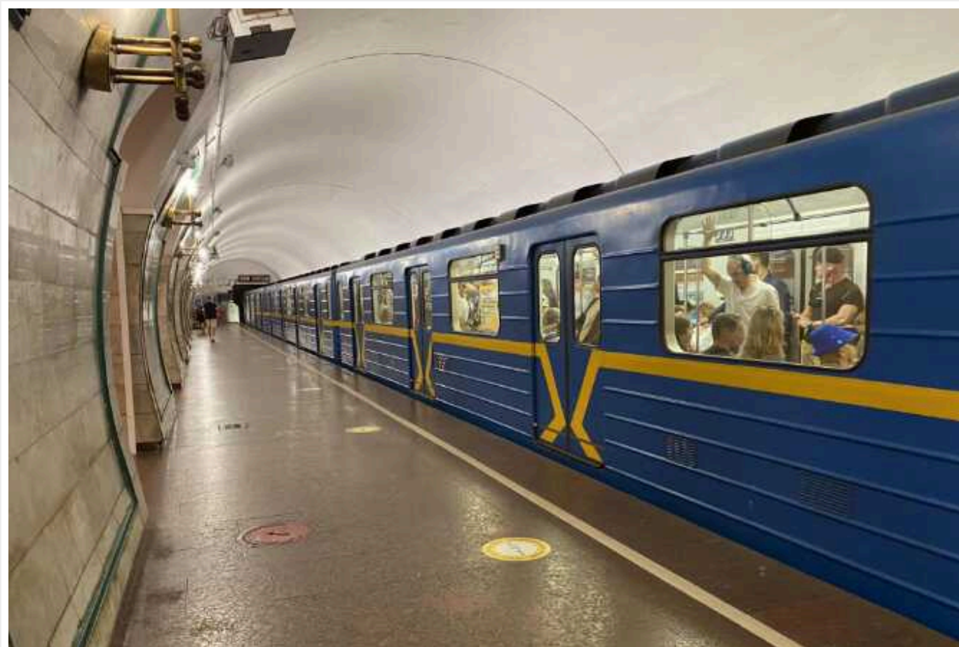
Тріщини та підтоплення на "синій" гілці Київського метро: очільник метрополітену розповів цікаві деталі
