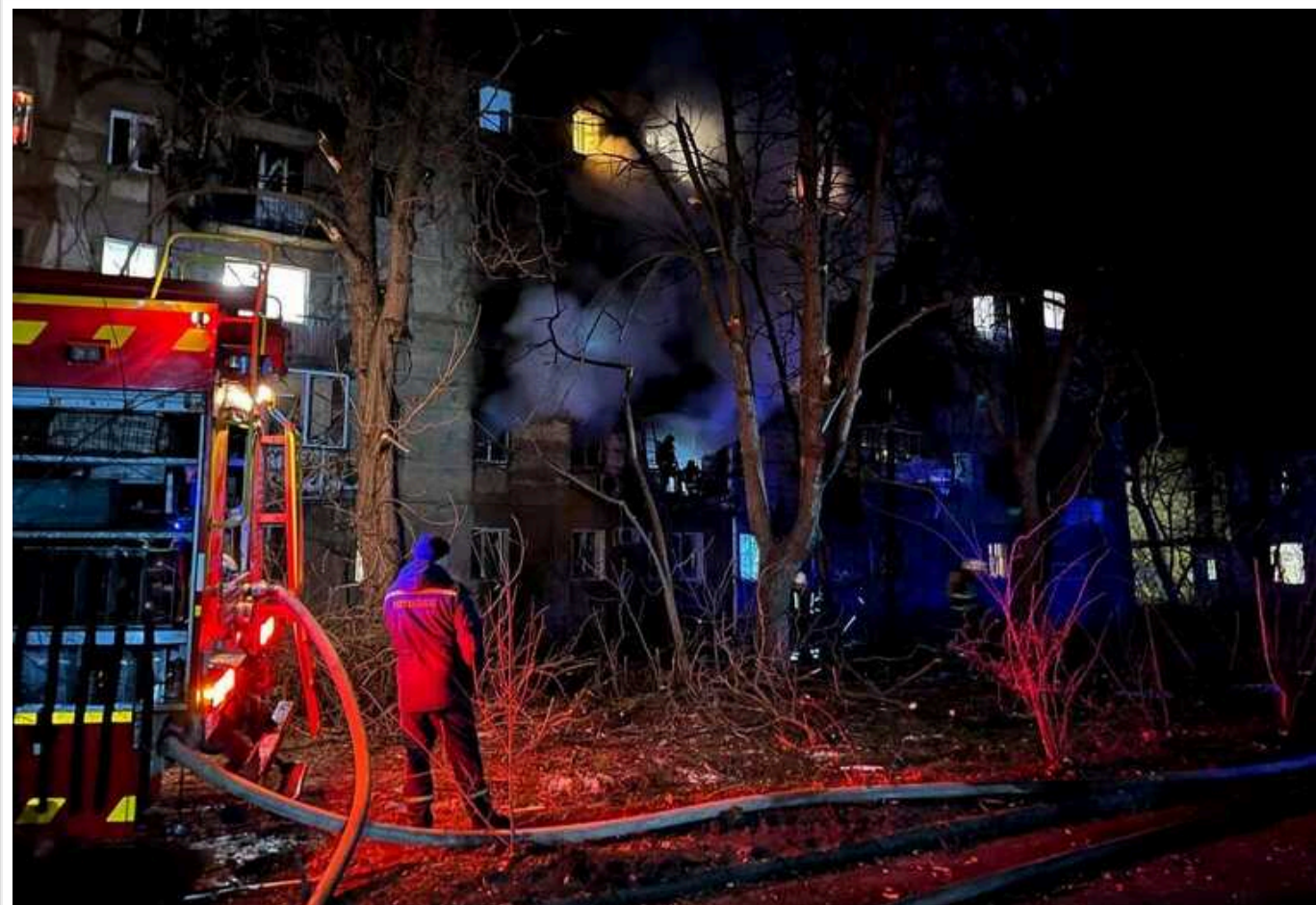
Нові деталі удару по Одесі: зруйновано фасад будинку, знищено автомобілі
