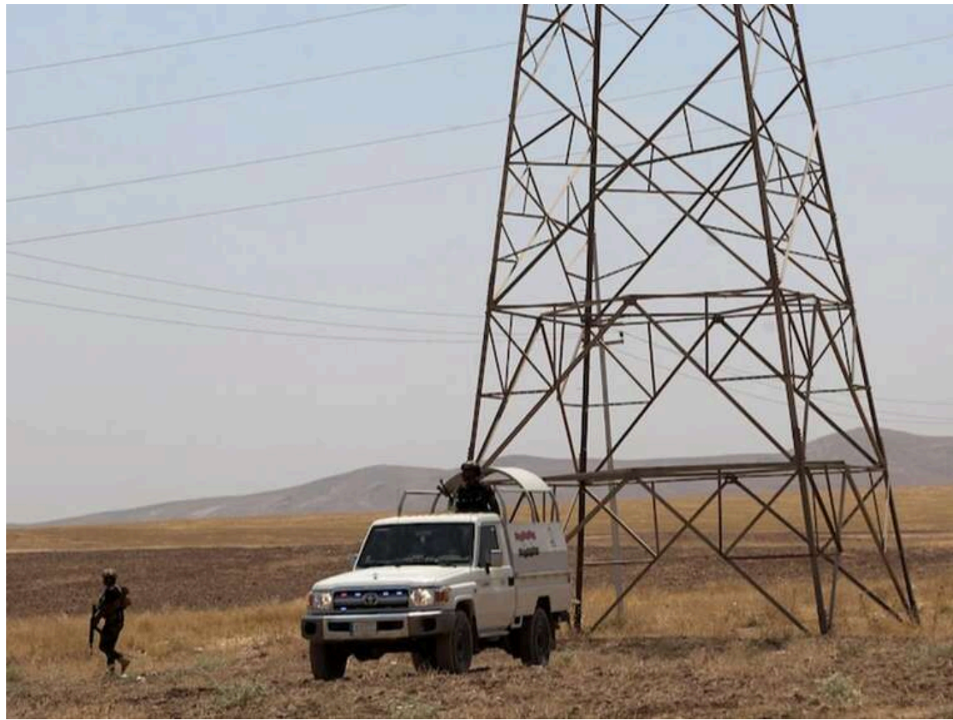
В Ірпені блискавка влучила в електропідстанцію
