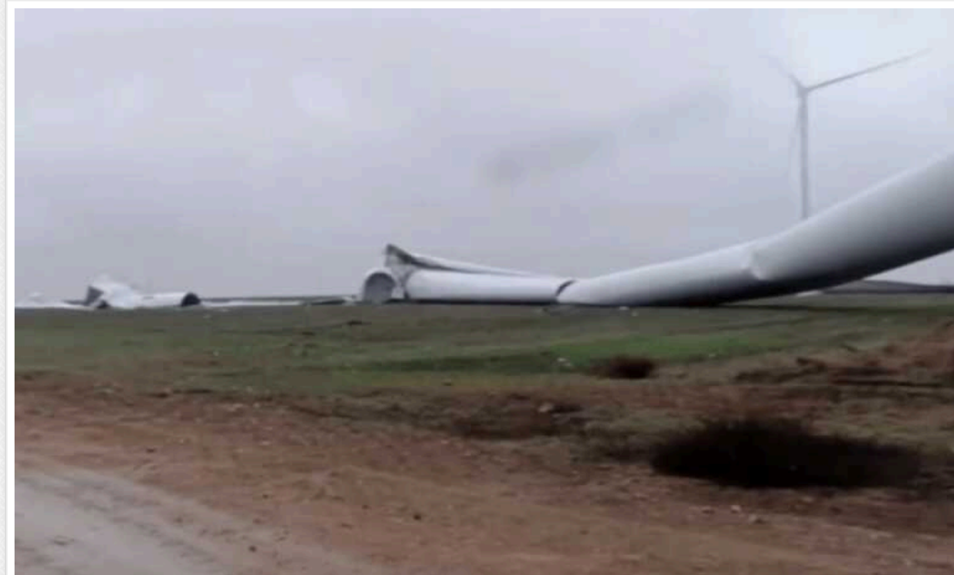
У Міненерго назвали причину падіння вітрогенератора під Одесою
