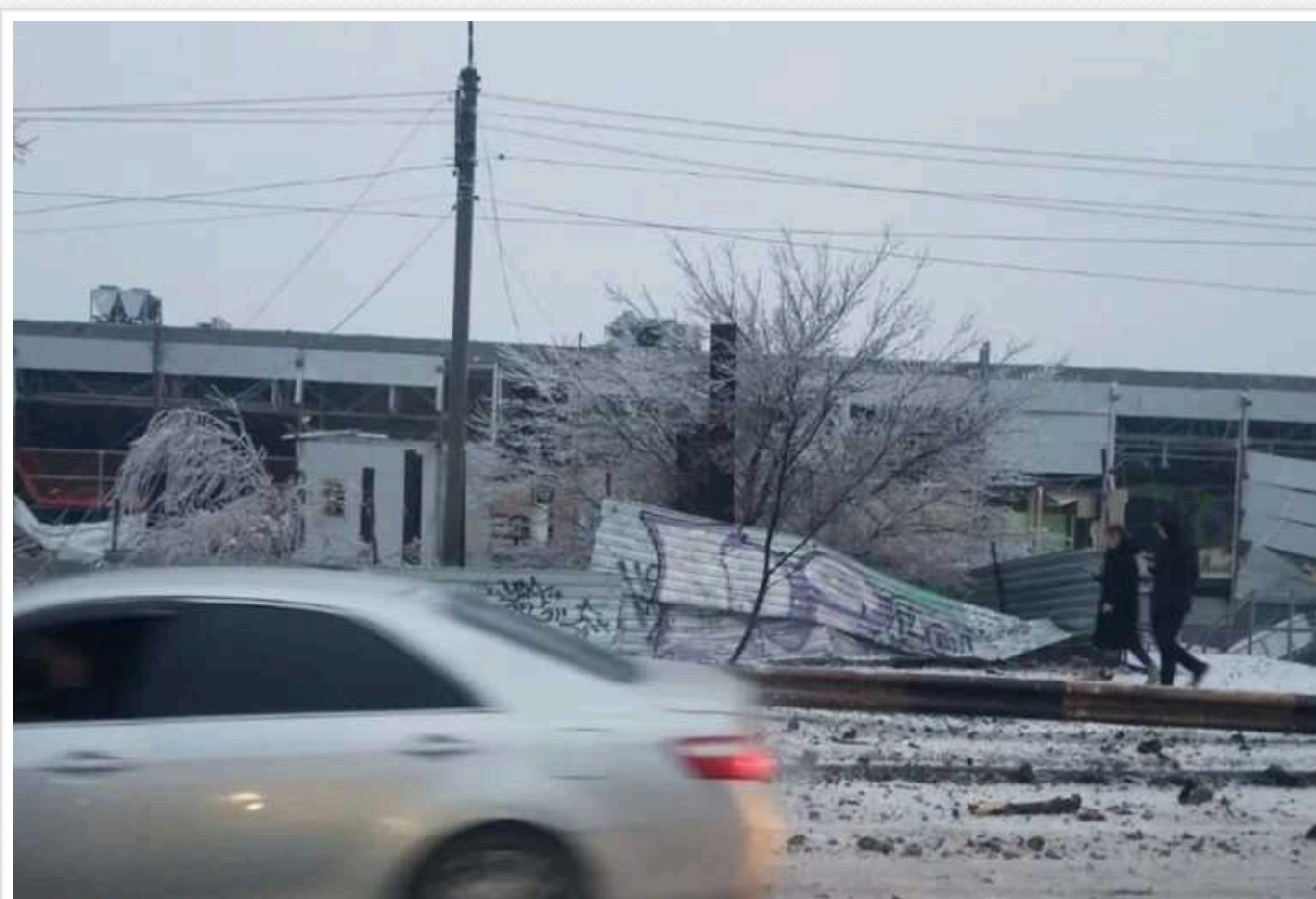
Наслідки удару РФ по Кривому Рогу: пошкоджено ТЦ і десятки будинків
