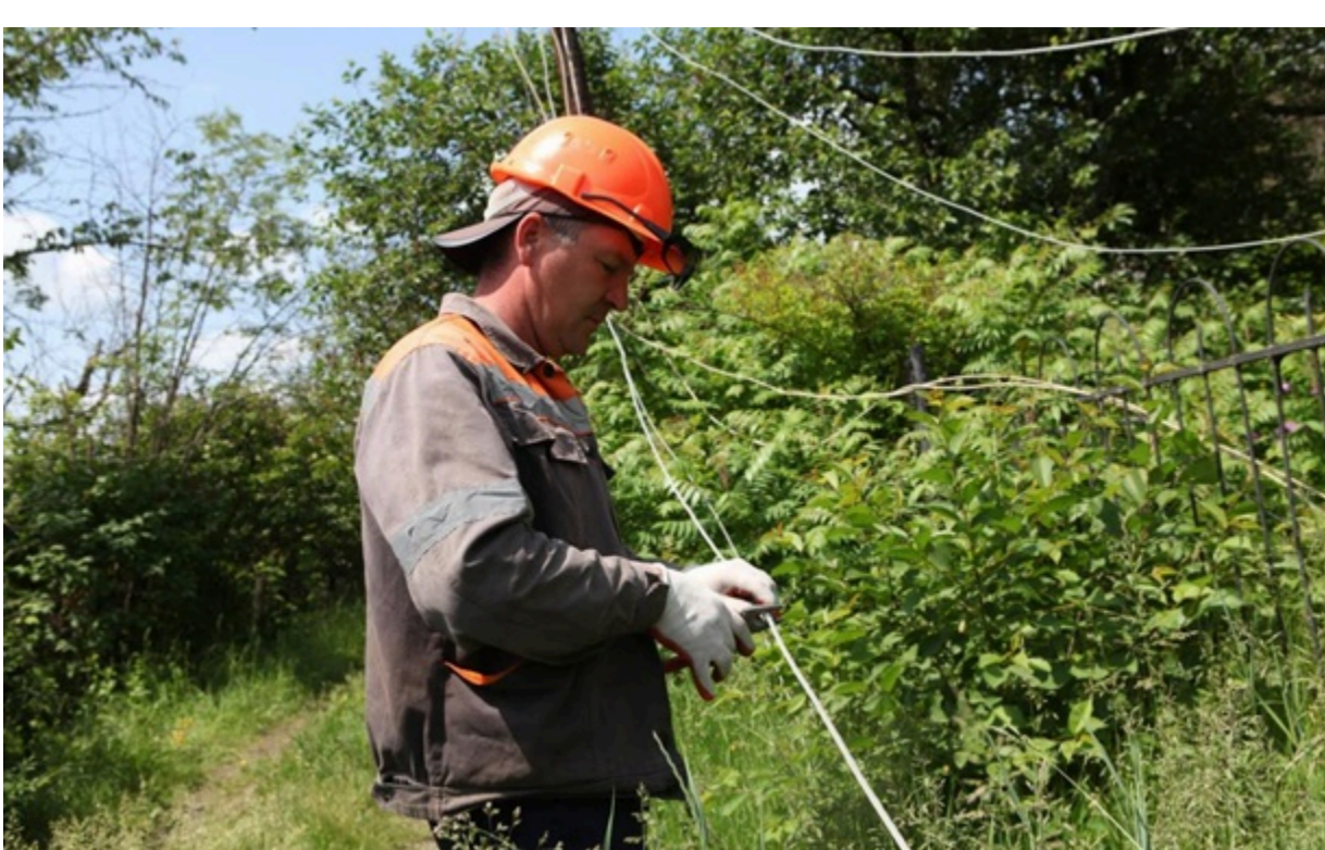
Фото: Укренерго В енергетиків додалося роботи через нові обстріли і негодю
