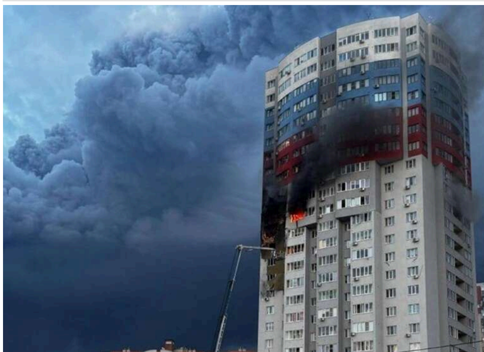
У Рязані атаковано один із найбільших НПЗ потужністю 17 мільйонів тонн: зафіксовано влучання в житловий будинок
