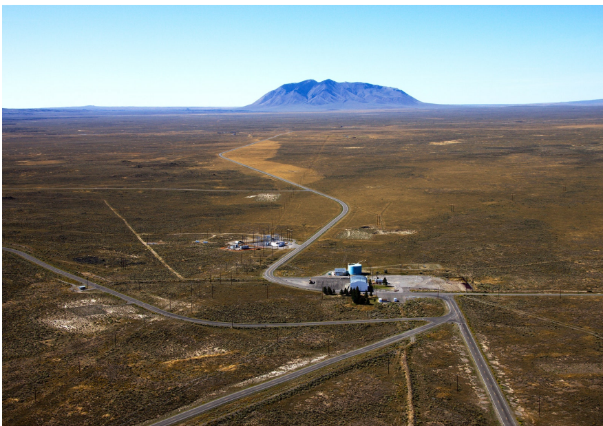
Электрическая подстанция в национальных лабораториях Айдахо, на испытательном полигоне площадью 2300 кв.км.
