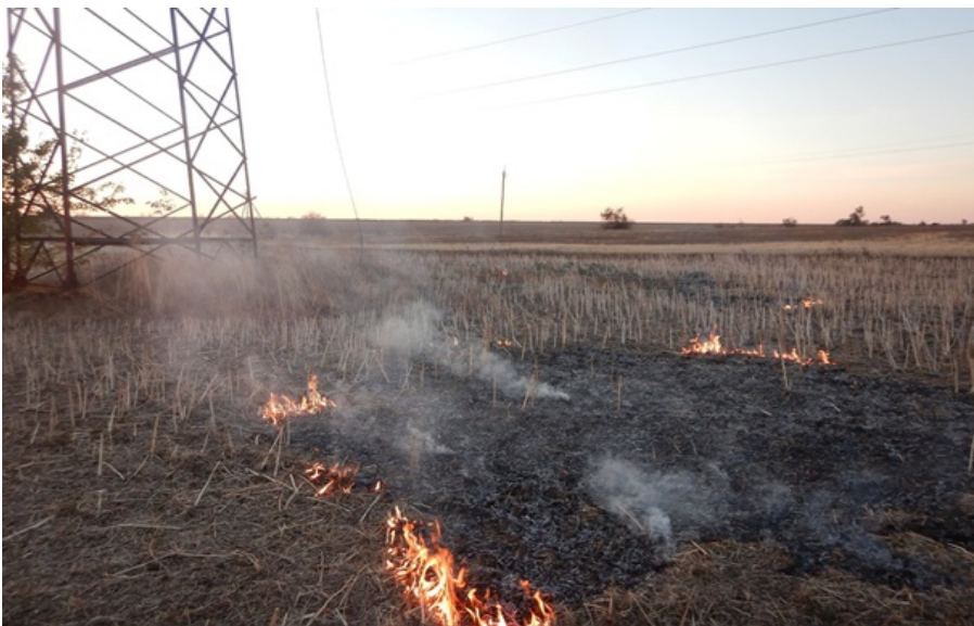
Фото: Укренерго Пошкоджені мережі через російську атаку
