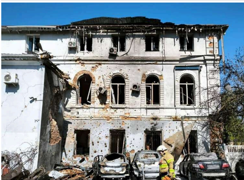
Удар «шахеда» по Чернігову: пошкоджено будівлю окружної прокуратури, є постраждалі
