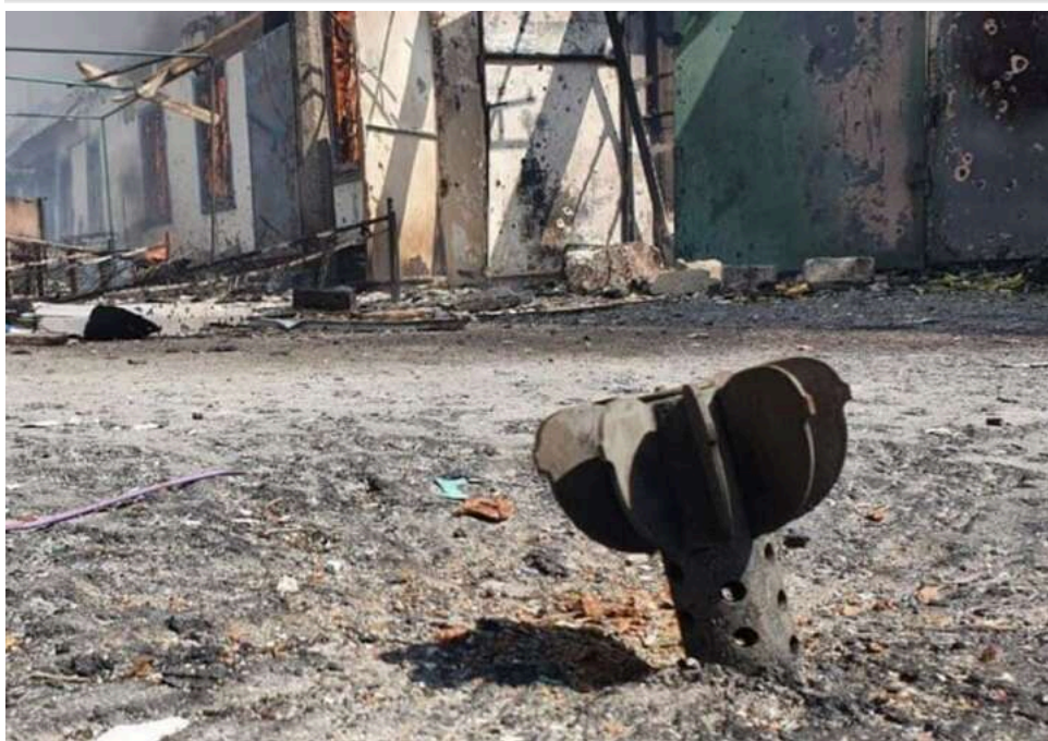
РФ скинула 9 керованих авіабомб на Херсонщину: є руйнування
