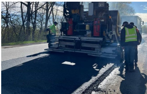
Фото: ремонт дороги (t.me/svyrydenko)
