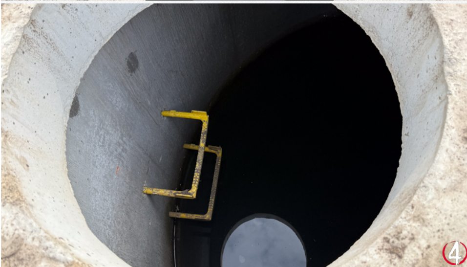
Вигляд зі сторони Басівкутського водосховища на очисну споруду по вулиці Спаська, що встановили, але ще не запустили в межах капітального ремонту вулиці Чорновола:
