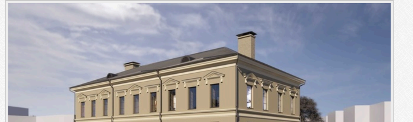
Стан виконання реставрації будинку на вул. Сковороди, 9-Б, грудень 2021 року (джерело – сторінка у Facebook Антона Короба)
