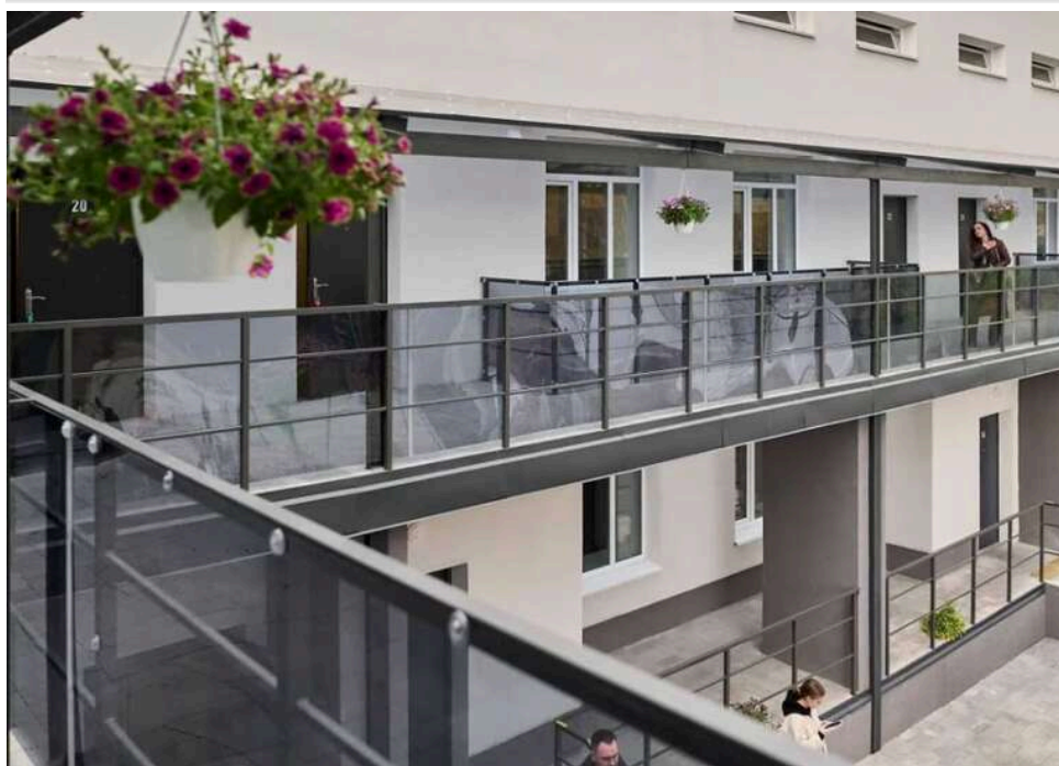
У Славутичі облаштували 34 квартири для ВПО в будівлі колишньої лікарні
