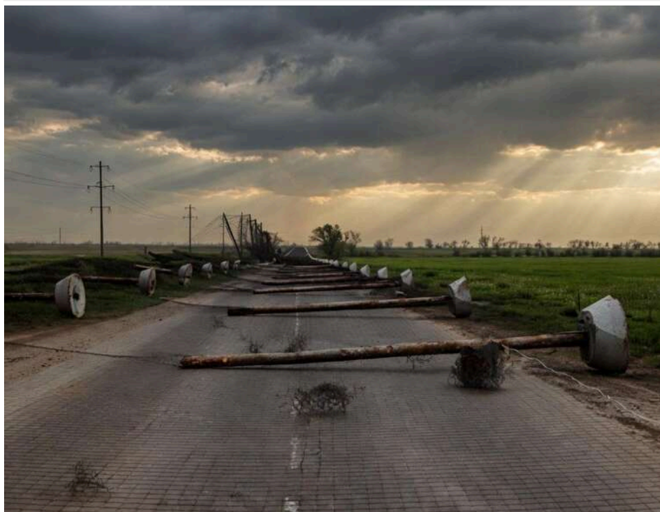
Сильний вітер пошкодив антидронові конструкції під Херсоном
