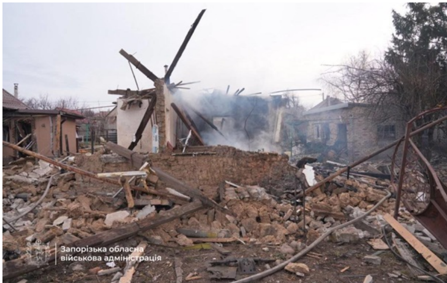
Фото: Запорізька ОВА Разрушенный дом в Запорожье
