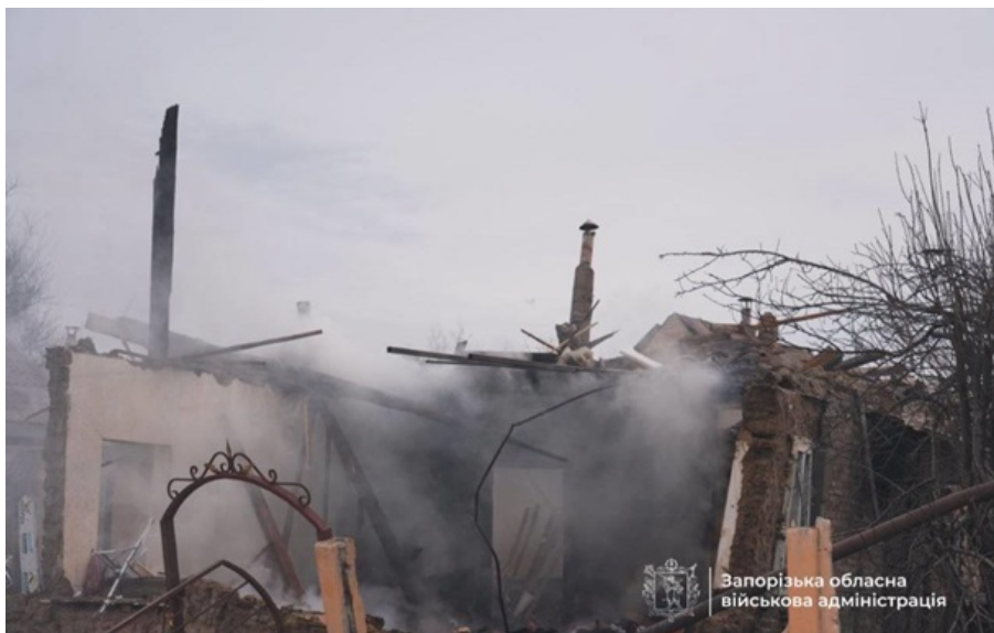
Фото: Запорізька ОВА Разрушенный дом в Запорожье
